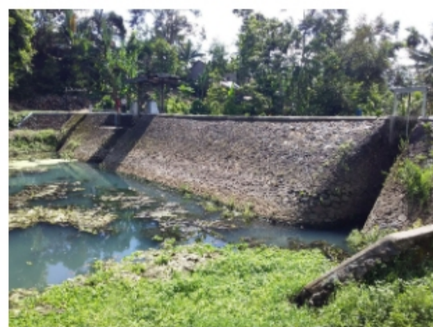
BENDUNG TETAP TOJANG
